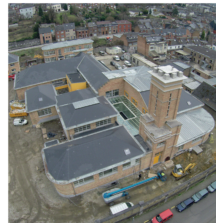
Les Abattoirs de Bomel en cours de rénovation (2013)
