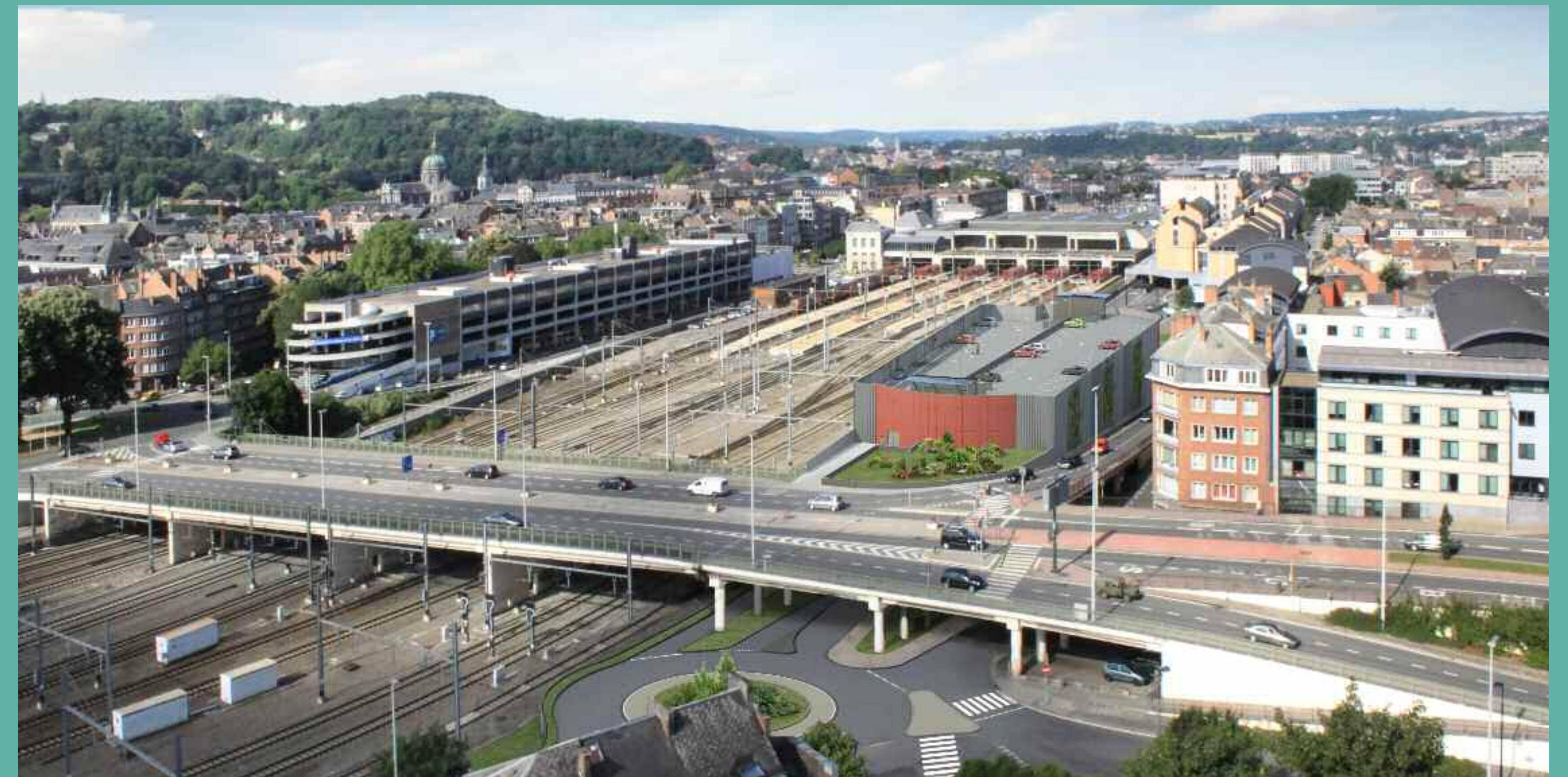
Nouveau rond-point et by-pass sous le futur parking SNCB
