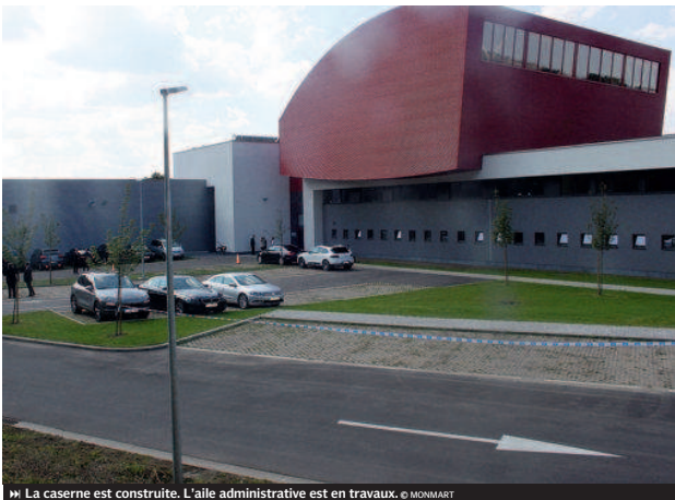
▶ La caserne est construite. L'aile administrative est en travaux. © MONMART
