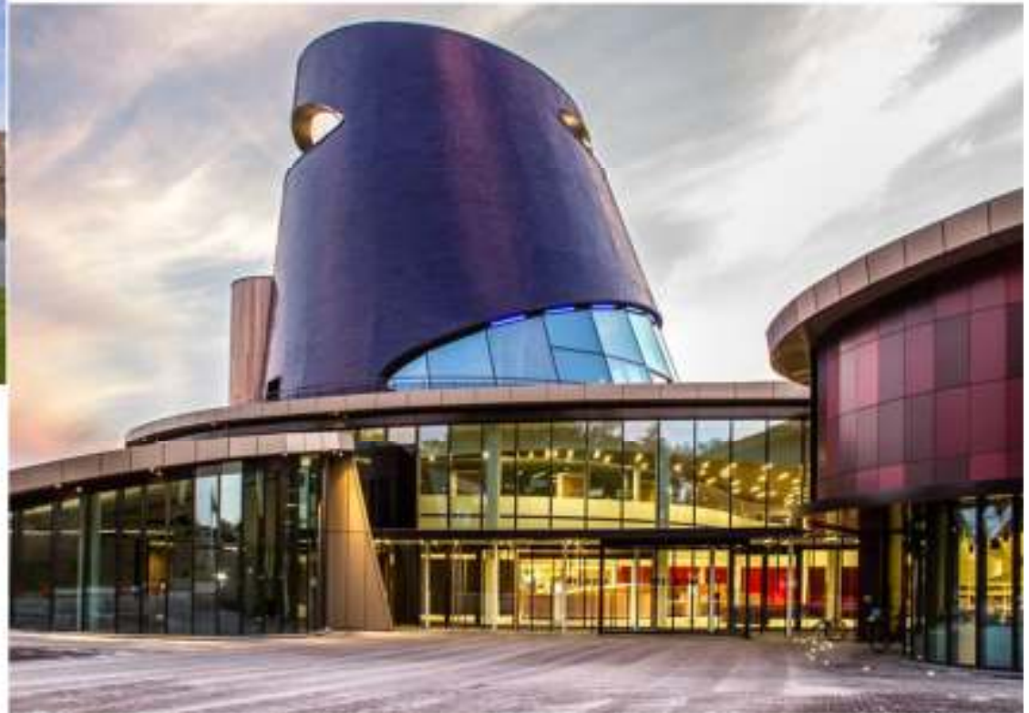
Centre administratif à Houthalen
