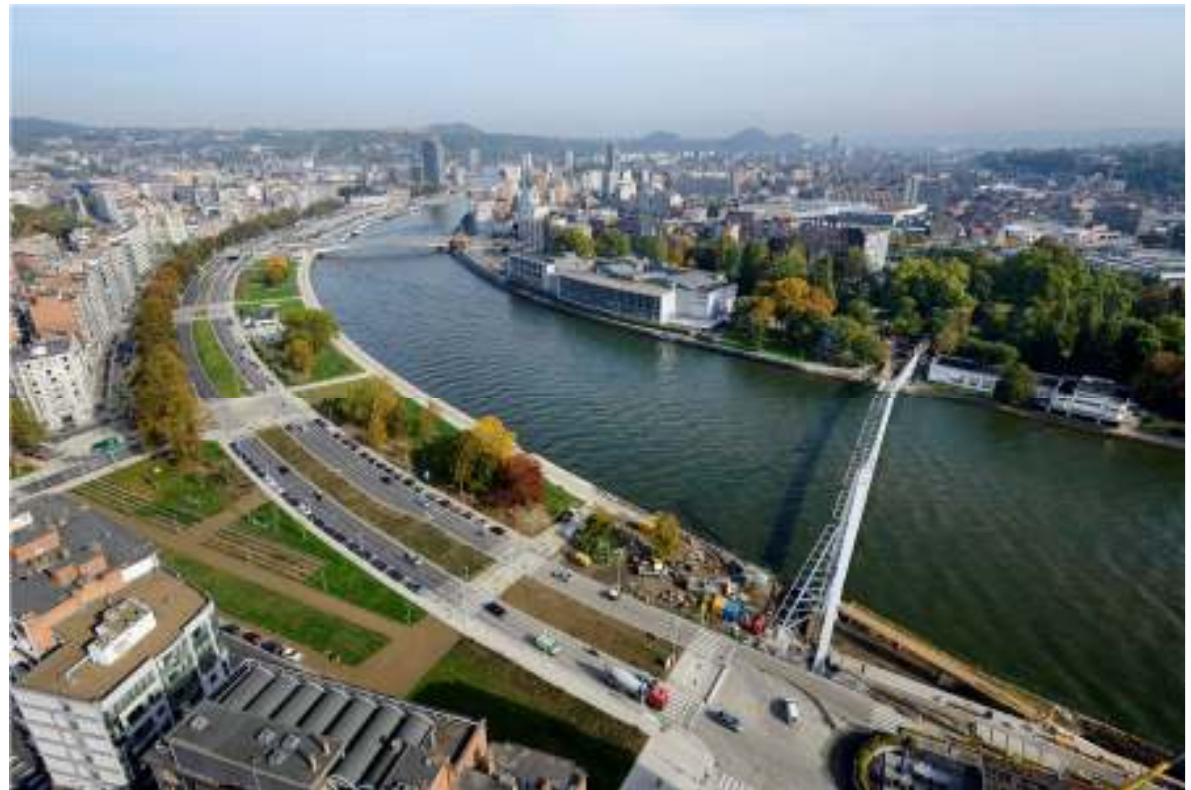
Aménagement Quais de Meuse à Liège
